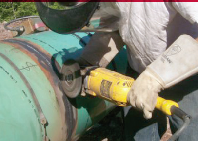
Limpieza de soldadura en unión de tubería
