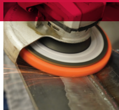
Limpieza de soldaduras con un disco.
