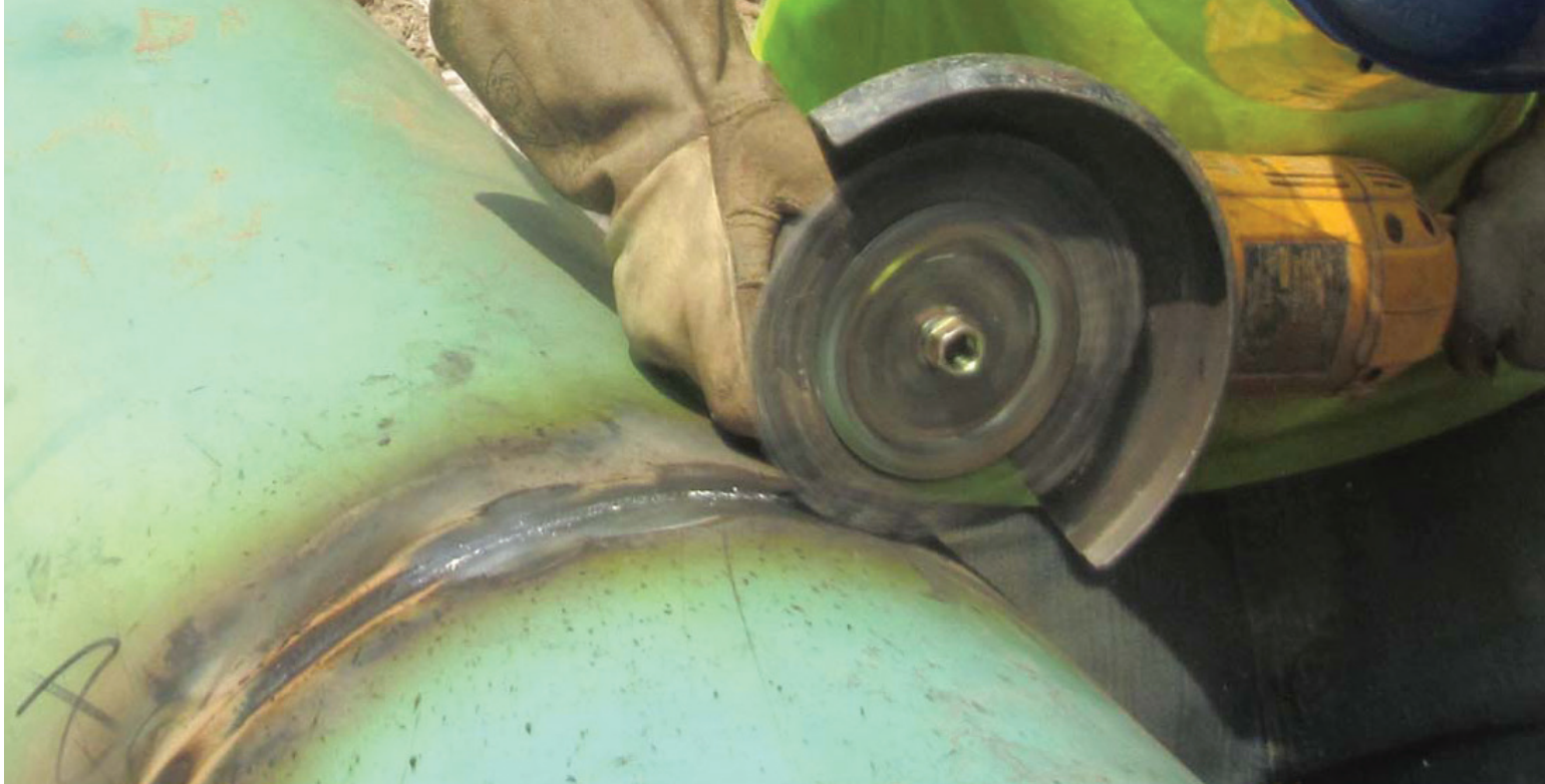
Limpieza de soldadura de pase de raíz en tendido de tubería.
